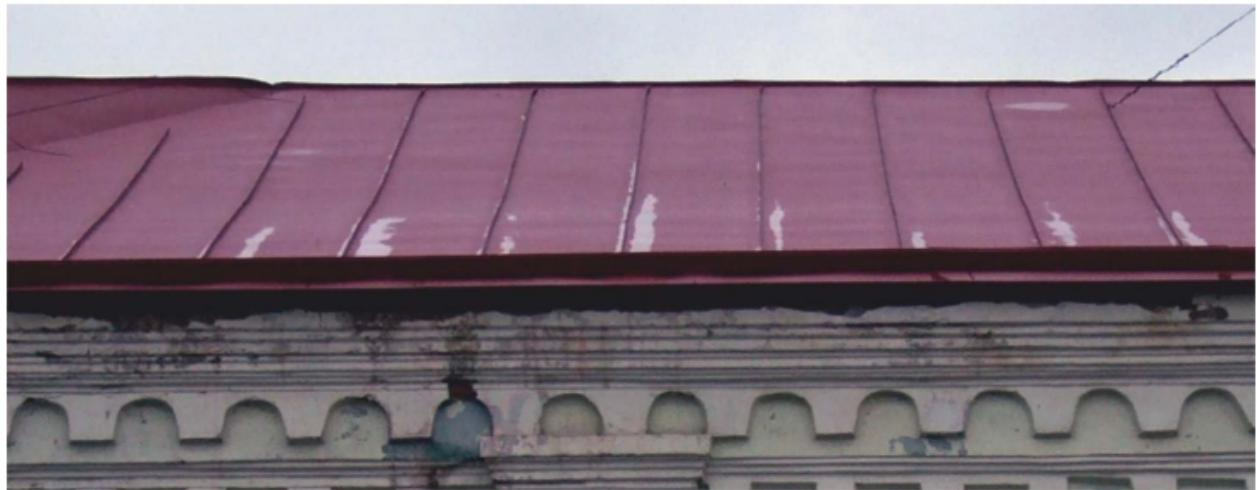
Рисунок 17. Результат некачественного обезжиривания поверхности.
