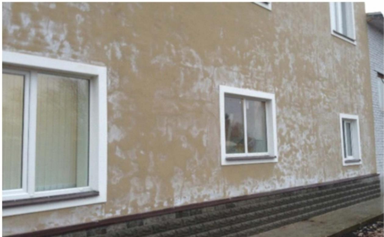
Рисунок 11. Окрашивание нового здания без выдержки штукатурки, осенью без отопления после дождя с ветром.
