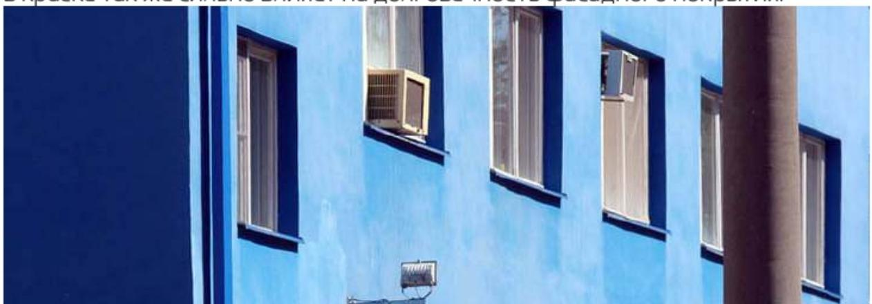
Рисунок 15. При окрашивании превышена допустимая концентрация органического пигмента. Со временем он выгорел на солнце и вымылся дождем.
