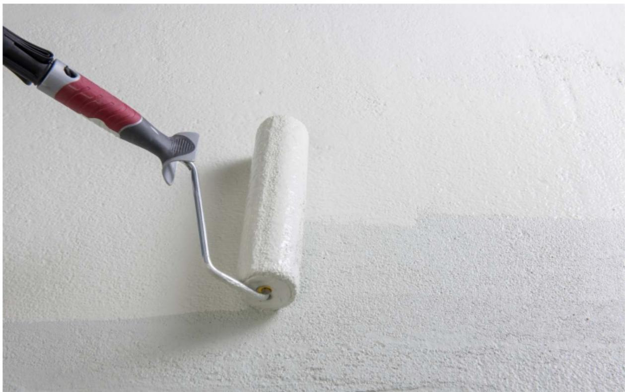
Рисунок 23. Окрашивание Бетонного пола.
