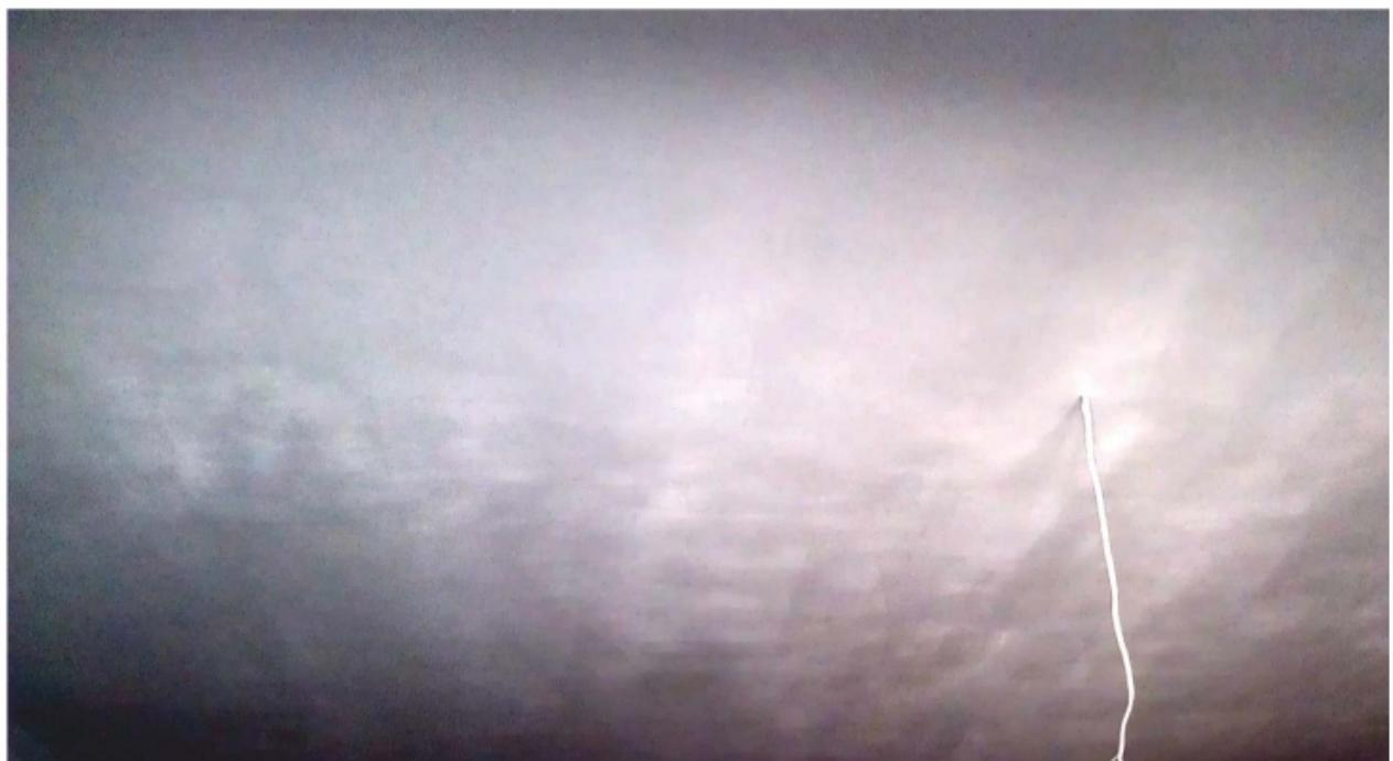
Рисунок 26. Полосы на потолке после окрашивания.
